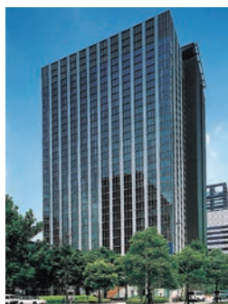
住友生命本社ビル
