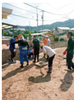
西日本豪雨土砂撤去
