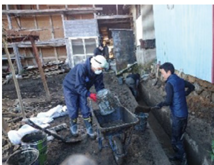
2019年台風19号丸森町土砂撤去
