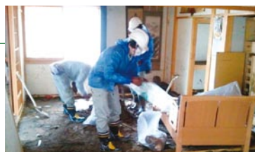
がれき撤去の様子
