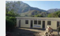
完成したトイレと給水設備 ©プラン・インターナショナル
