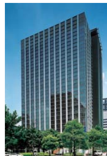
住友生命本社ビル
